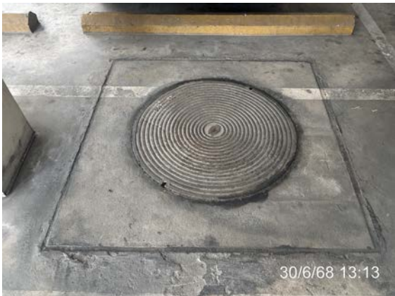
รูปที่ 2-8 บ่อหมุนน้ำใต้ดิน
